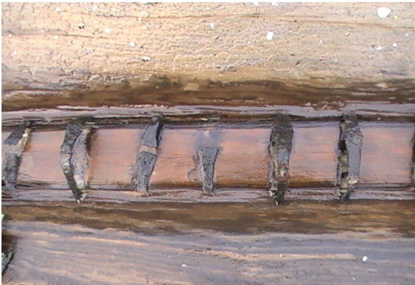
Küljeplangutuse triivlatt sinklitega. Foto Tõnis Rohtma
