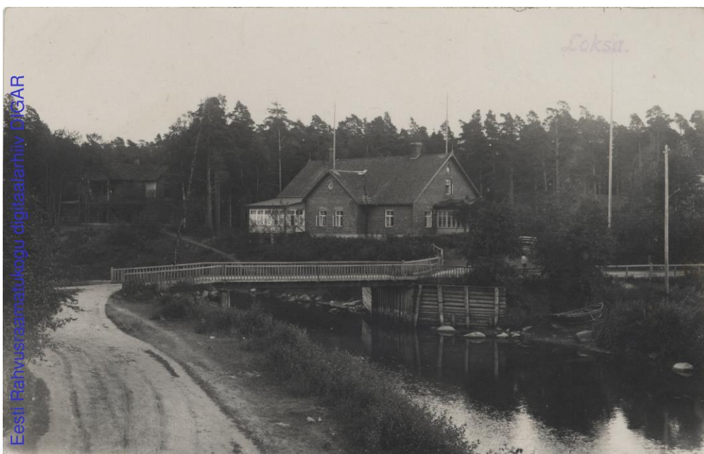
Tellisetehasele kuulunud Mühleni maja Lõksa-Nõmmes, ehitatud 1900.-1910. a. Paiku. Foto DIGAR
